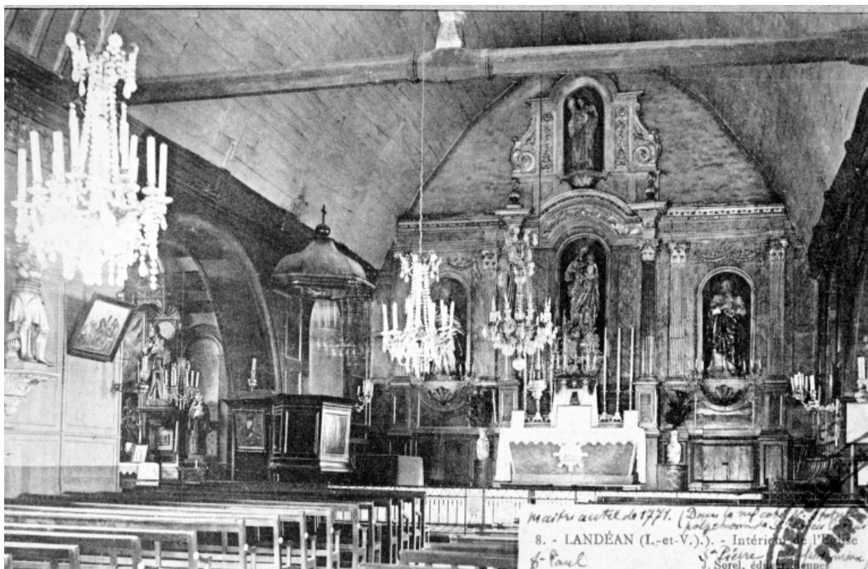
Carte postale ancienne - Intérieur, chœur : vue générale.
