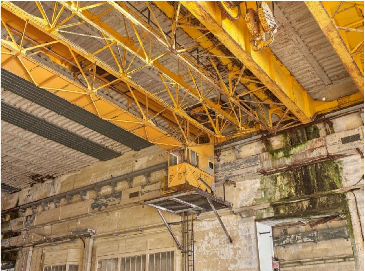
Vue du pont roulant avec son treuil. Il disposait d'une capacité maximum de levage de 5 tonnes
