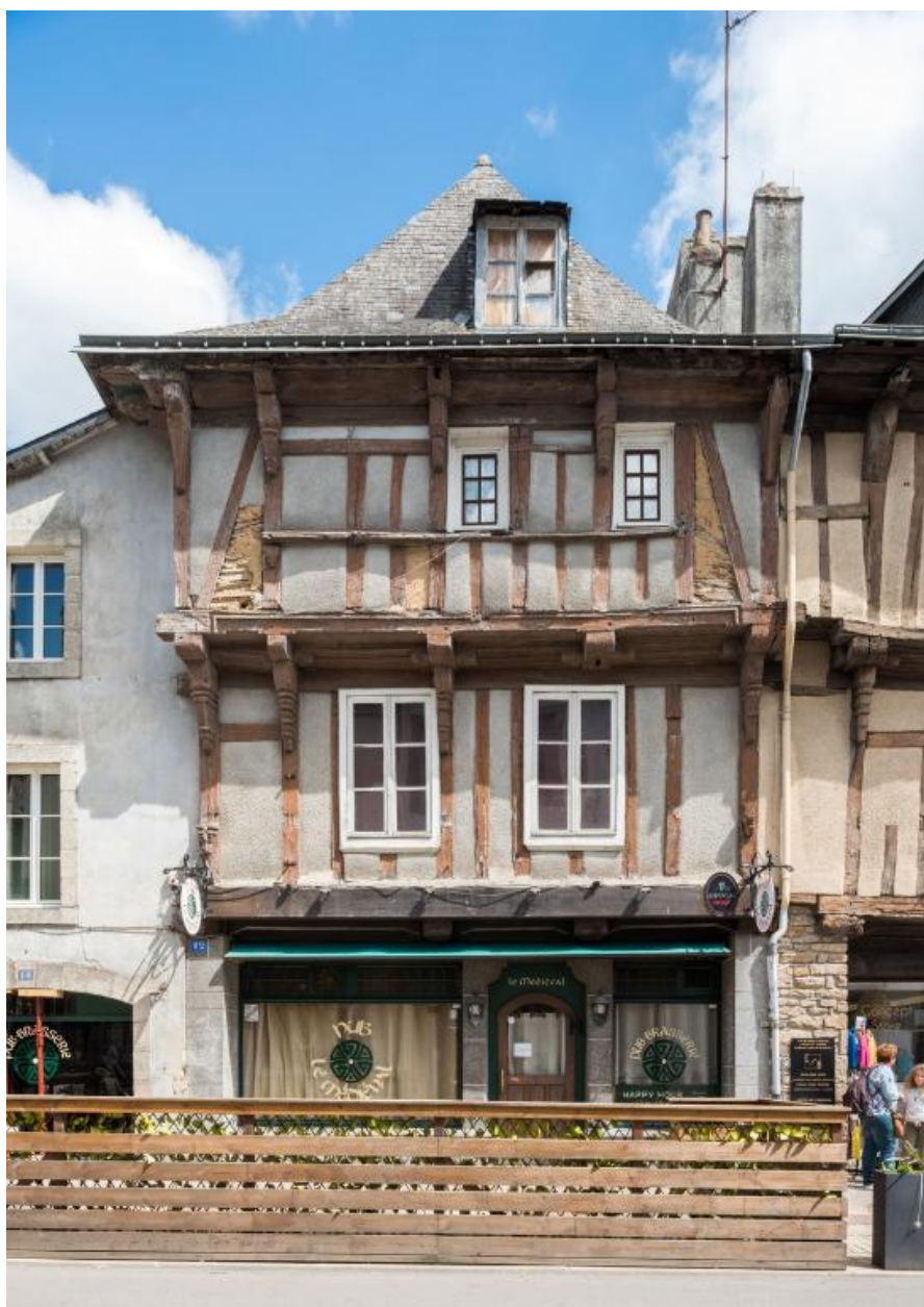
Façade en pan de bois en encorbellement sur solives donnant sur la rue principale.
