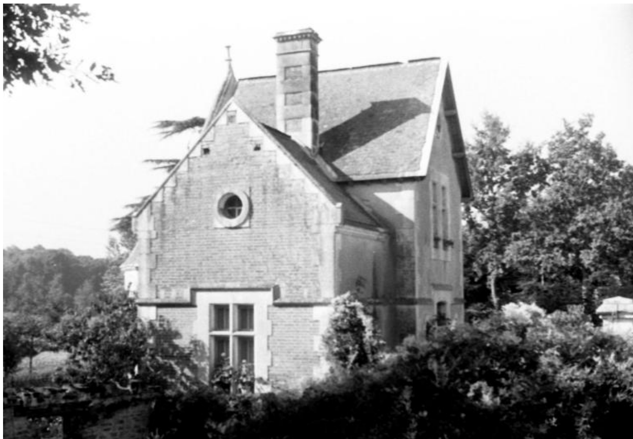
Chenil, vue générale.
