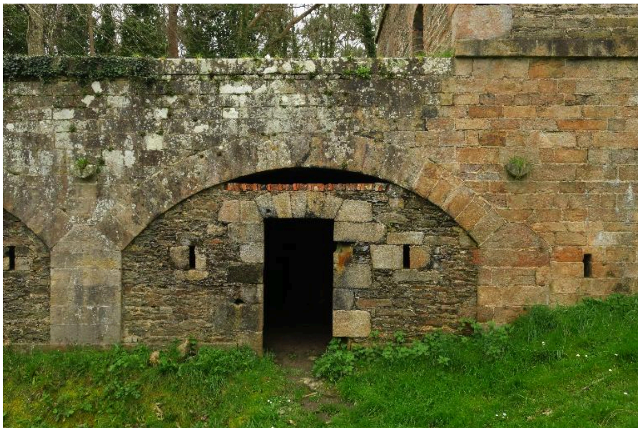
Le Palais, enceinte urbaine, galerie de contrescarpe, casemate à gauche du réduit H.
