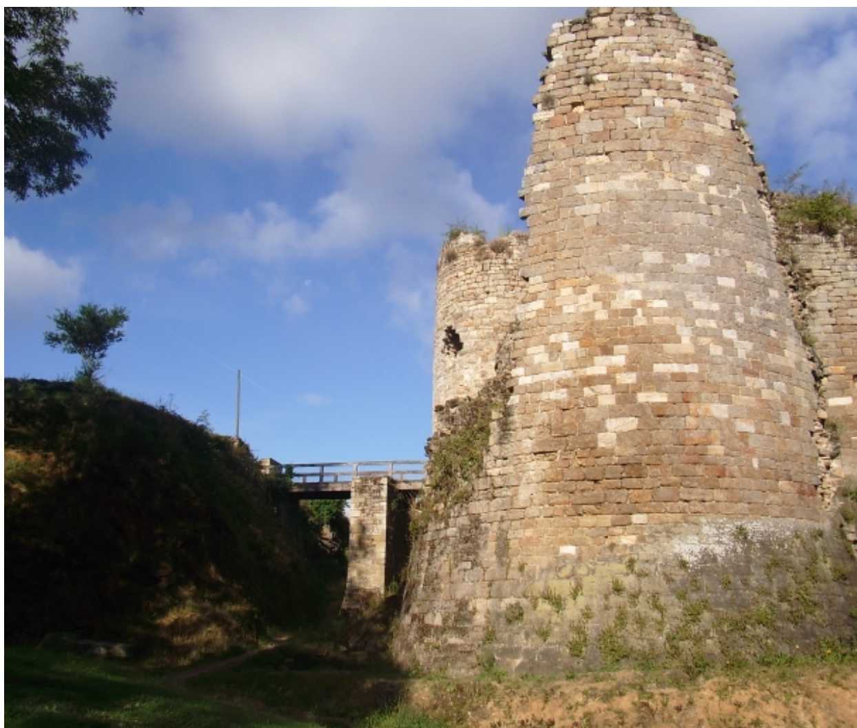
Tour d'angle sud-est et fossé sud
