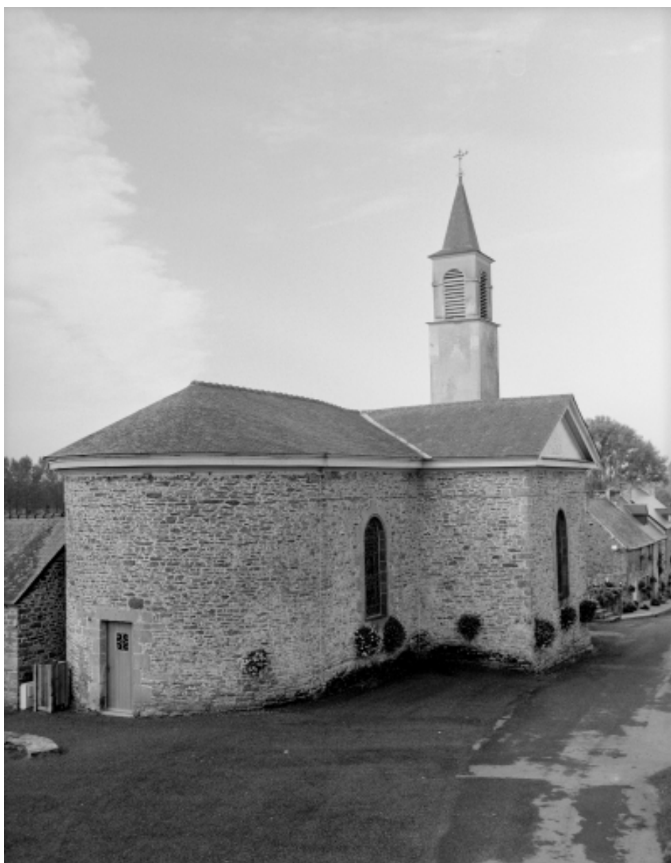
Elévation Nord-Est : vue générale
