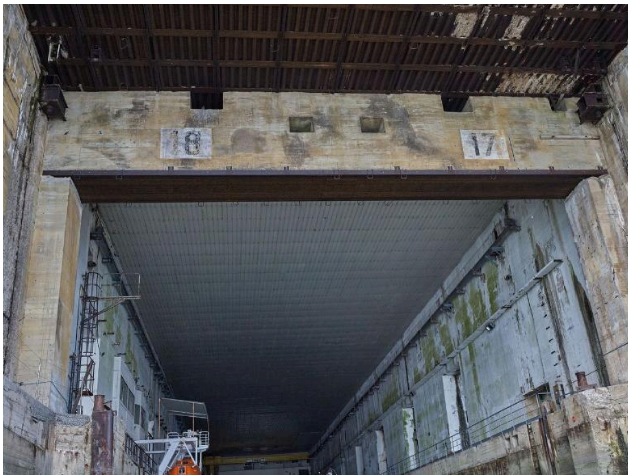
Vue de l'entrée de l'alvéole E (n° 17 et 18)
