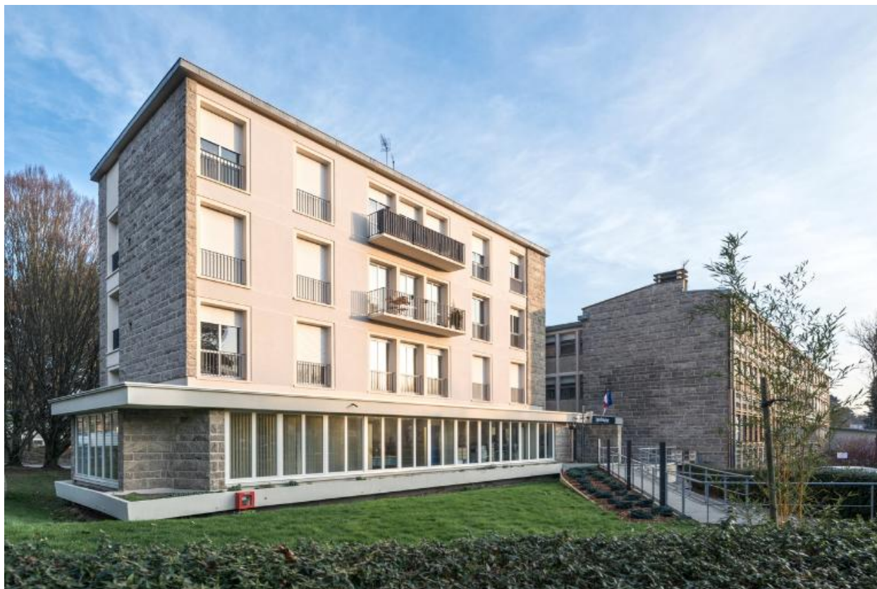
Bâtiment A, administration (RDC) et logements (étages), avant travaux de réhabilitation thermique.
