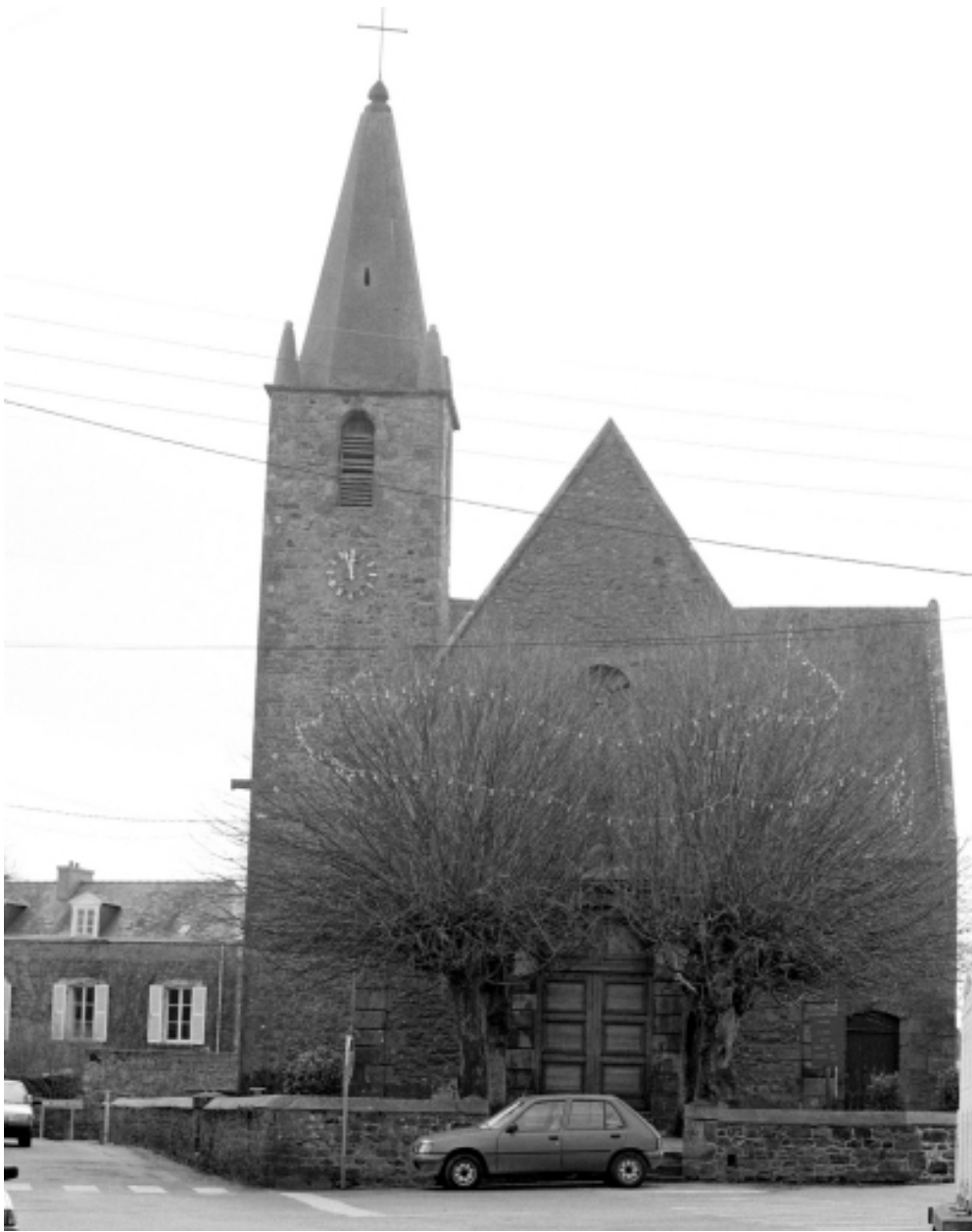
Elévation Ouest : vue générale
