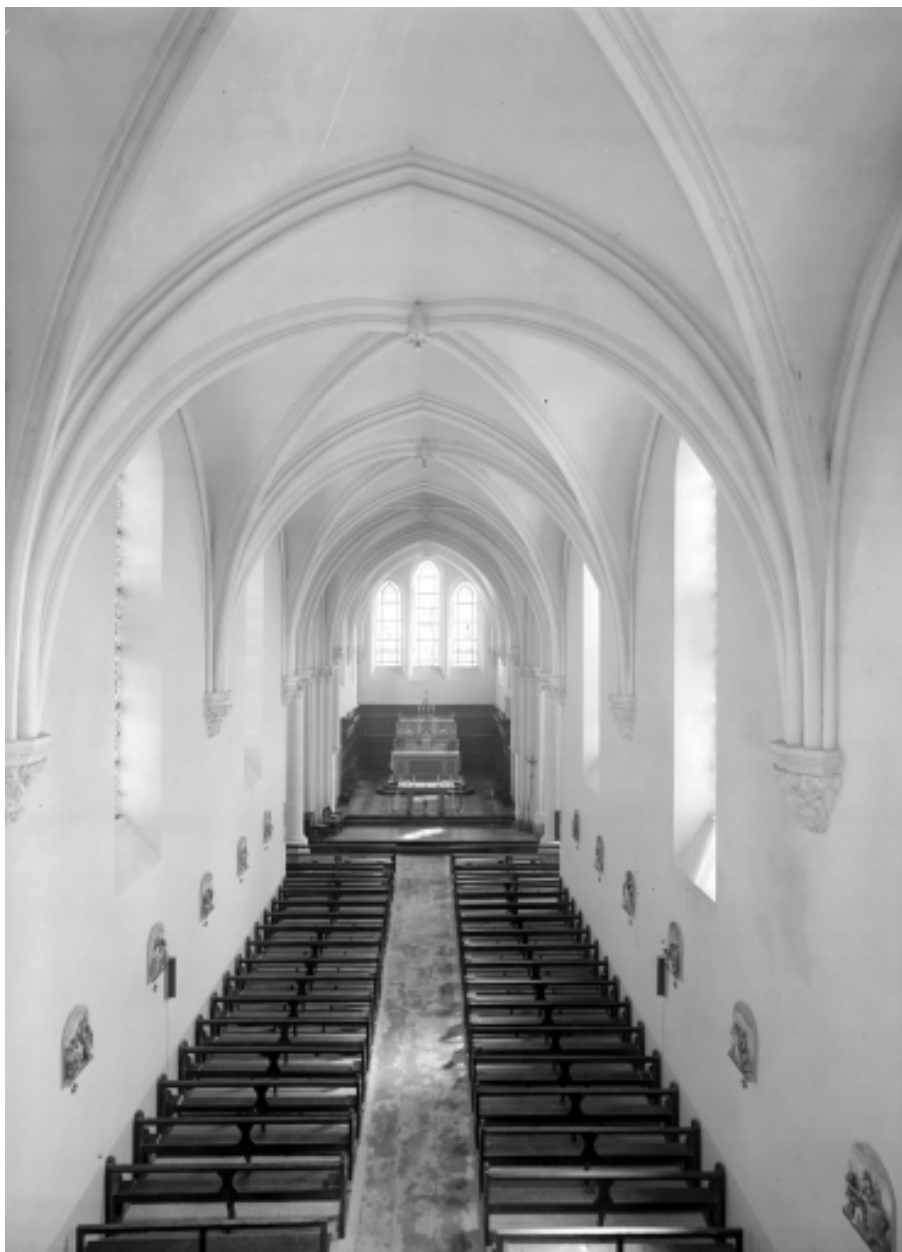
Vue générale intérieure prise d'ouest en est.
