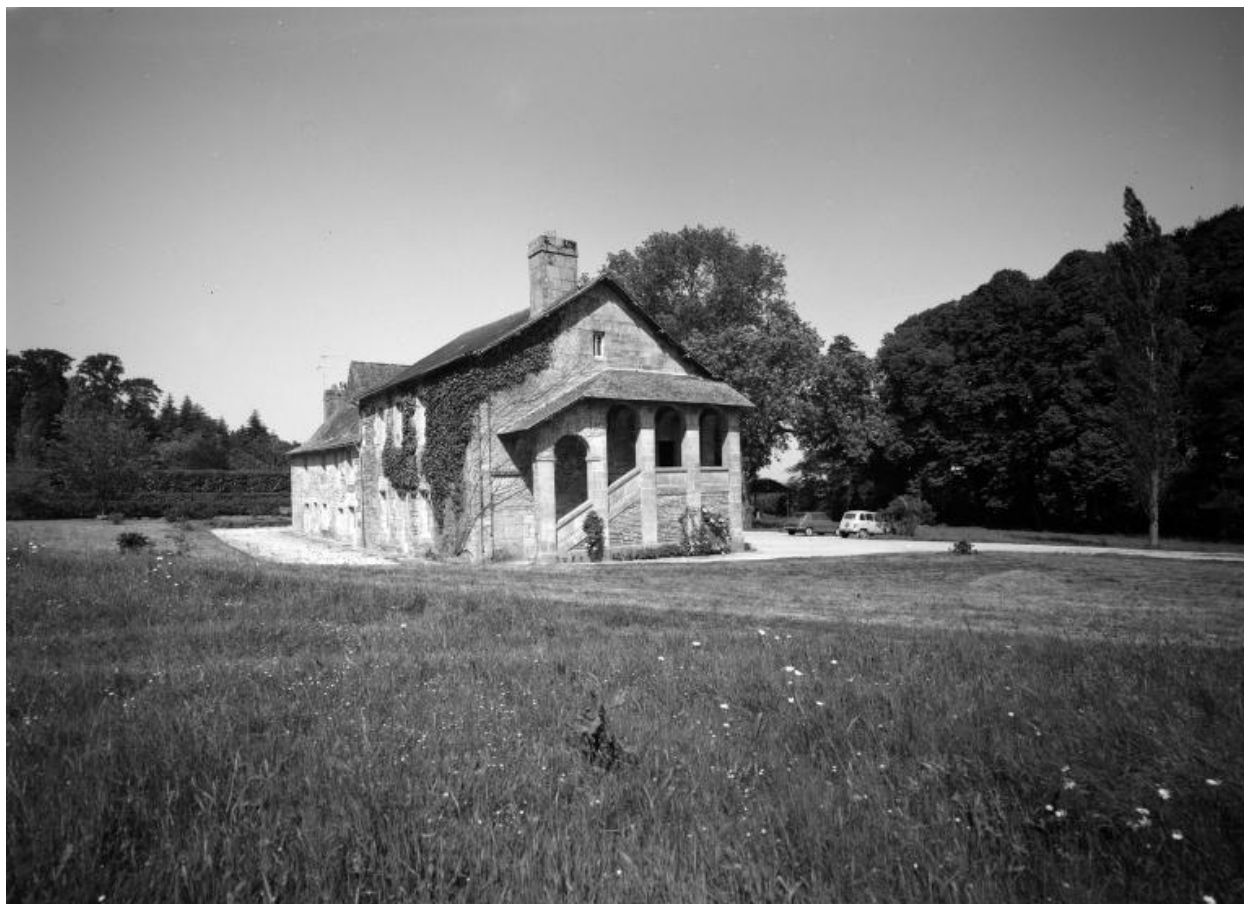
Vue de situation sud-est
