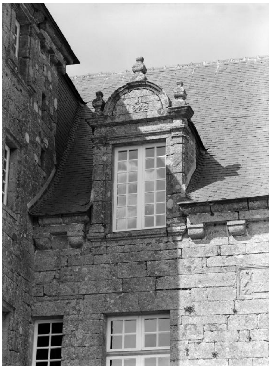
Lucarne et corniche sur la façade sud de la partie centrale
