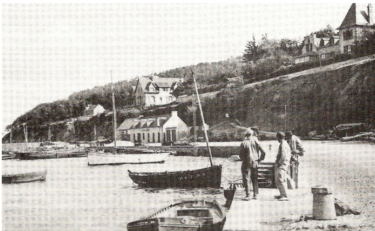
Vue ancienne de la zone portuaire du Kador
