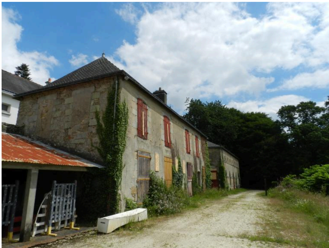
Communs de l'abbaye, partie logements
