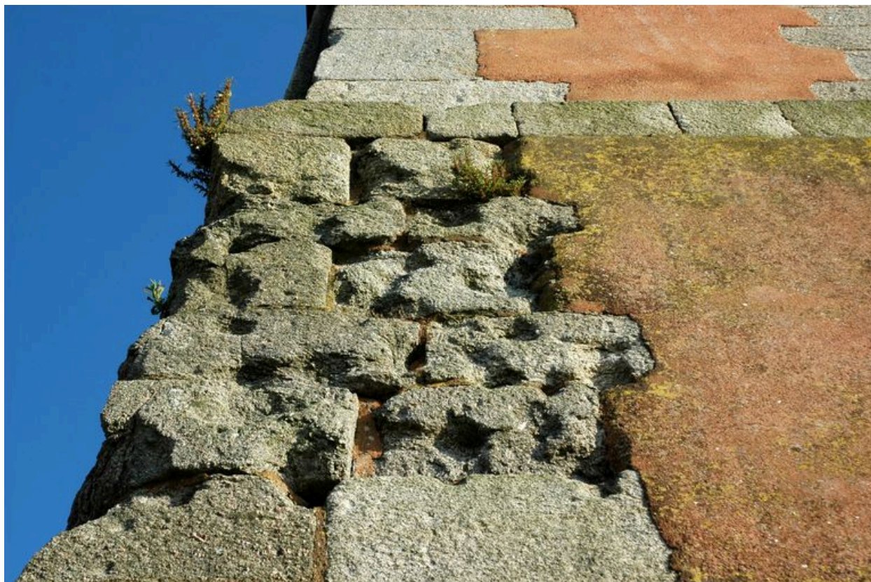
Vue de la Tour Vauban : impacts de boulets sur la face occidentale de la tour (une trentaine d'impacts sur 2 mètres carrés)
