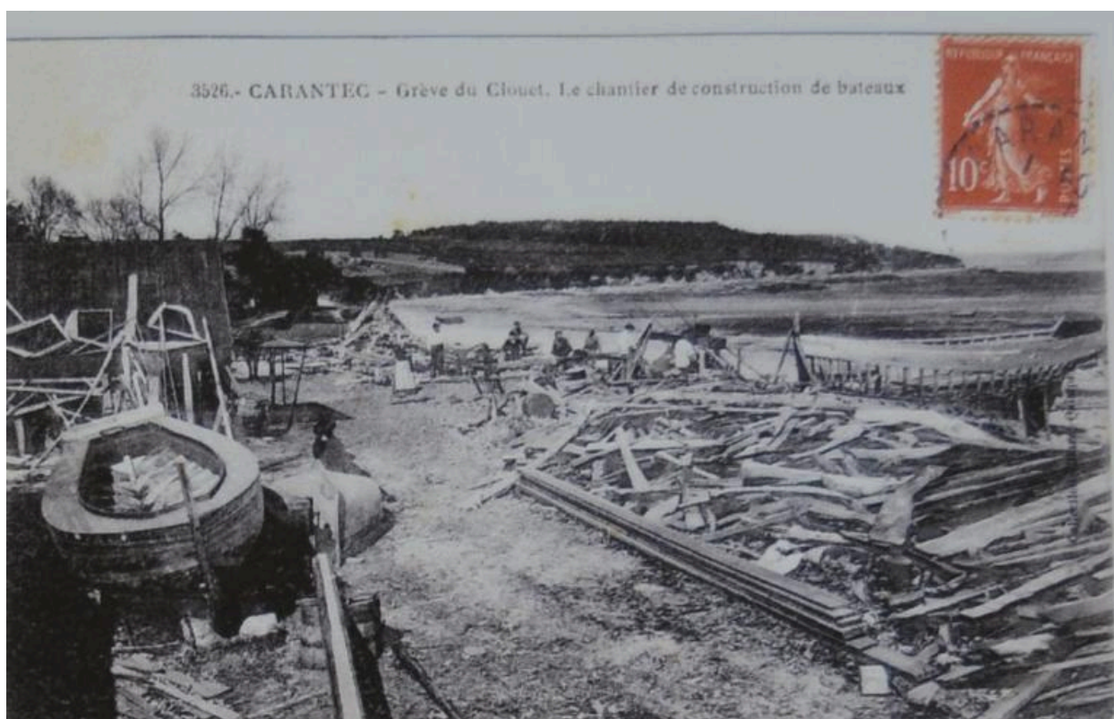
Chantier Pauvy, Clouët à Carantec
